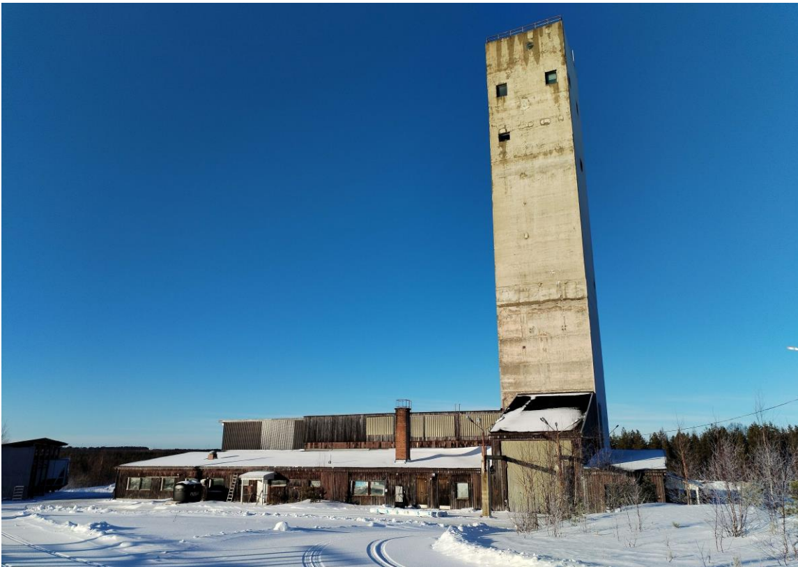
Kuva 46. Kaivostorni ja sen yhteydessä oleva rakennus. Kaivostorni on betonirakenteinen ja ulkomuodoltaan pelkistetty. Tornia ympäröi matala, lapekattoinen rakennus, jonka julkisivut ovat puuta ja peltiä. Rakennuksessa on mm. toimistotiloja, teollisen toiminnan tiloja ja varastotiloja. Ulkoasusta päätellen rakennusta on muutettu ja laajennettu useassa eri vaiheessa.
